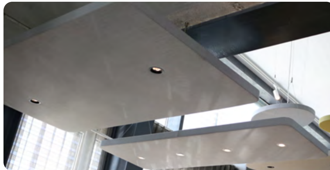
Screen50 LED Deckenabsorber optimieren Licht und Akustik im Raum
